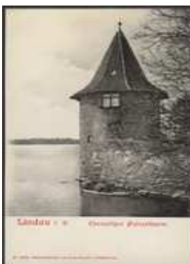
8990 Lindau Ehemaliger Pulverturm gelaufen nein
